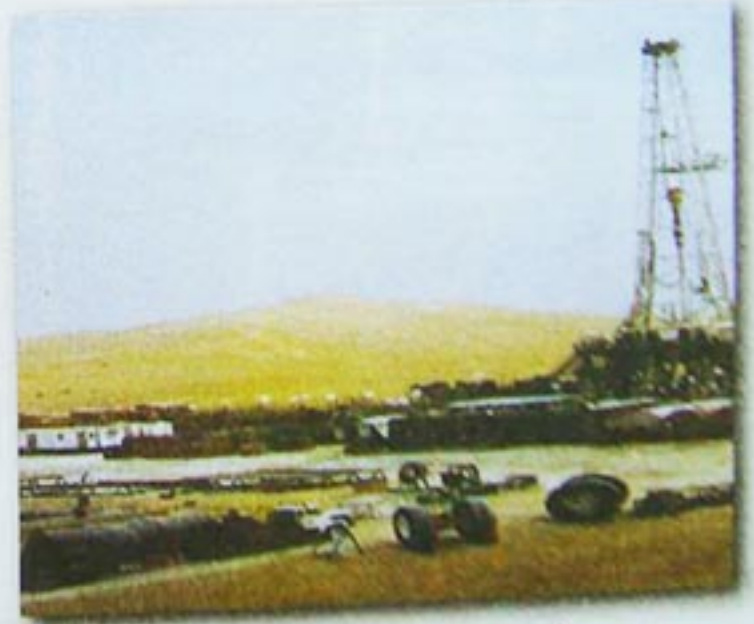
شكل (4) عملية الحفر في بئر بترولية
